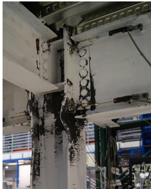
(d) Shear-tab connection "C" after Cyclic02 test
