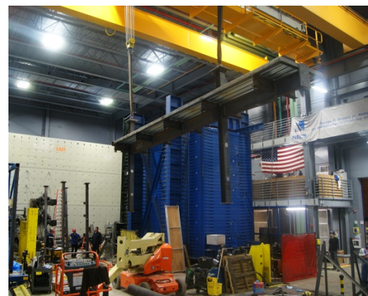
(d) Placement of Physical Sub-Structure #2
